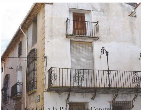
La casa dels Gil, a la Plaça de la Constitució, construïda el 1882
