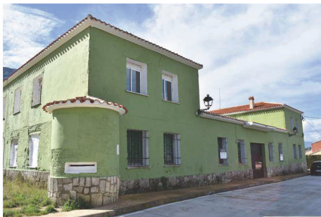
L'antic quarter de la Guàrdia Civil, obra del 1955
